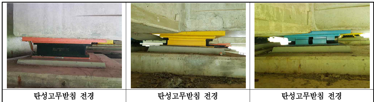
【사진 3.3.13】 교량받침 전경
