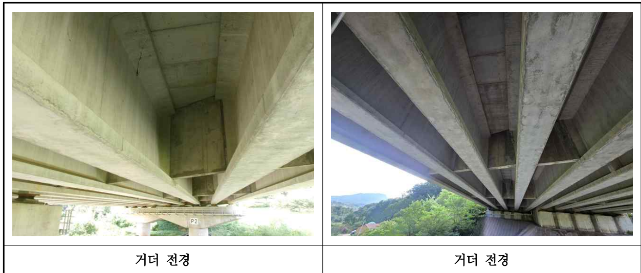
【사진 3.3.4】 거더 전경
