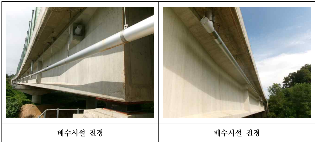
【사진 3.3.49】 배수시설 전경
