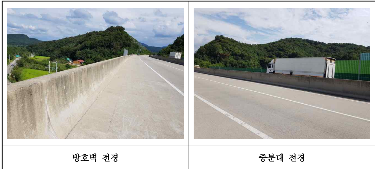
【사진 3.3.24】 방호벽 및 중앙분리대 전경
