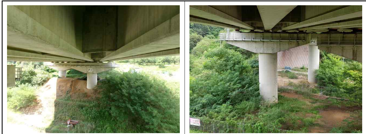
교각 코핑부 상태양호
