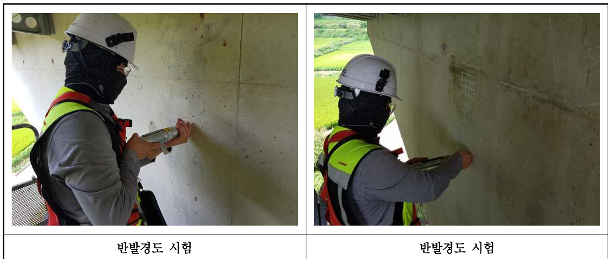
【사진 3.4.2】 반발경도시험 현장사진
