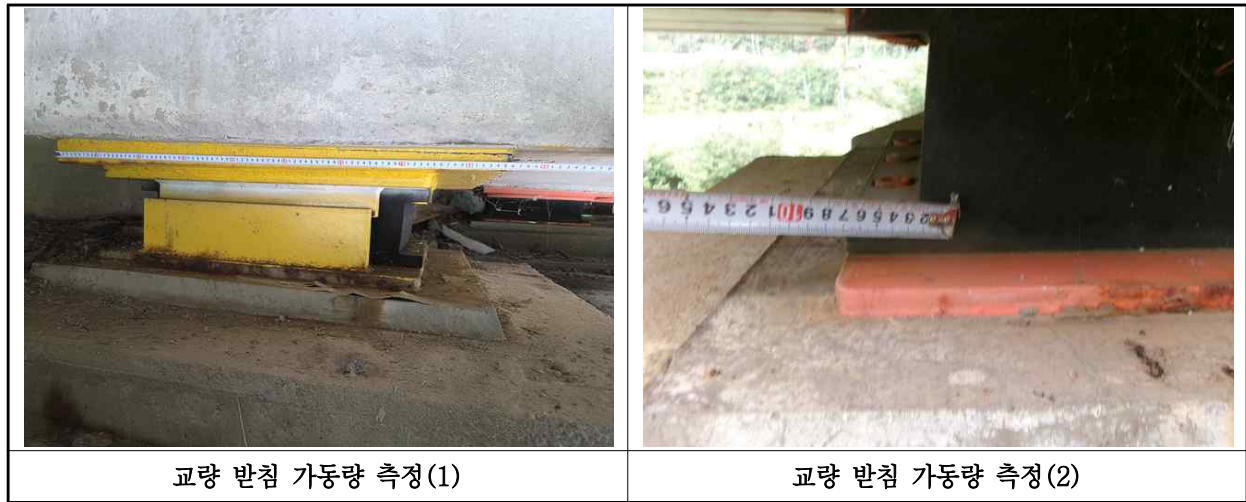
【사진 3.3.43】 교량받침 이동량 측정
