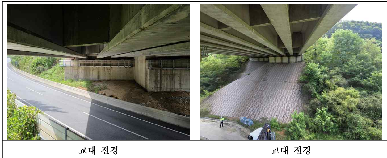
【사진 3.3.35】 교대 전경
