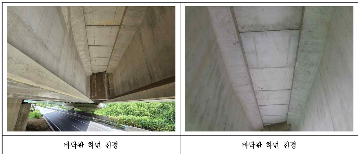
【사진 3.3.29】 바닥판하면 전경
