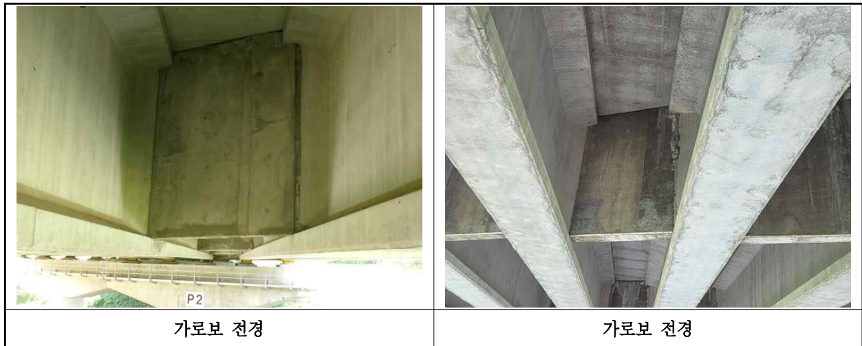
【사진 3.3.6】 가로보 전경
