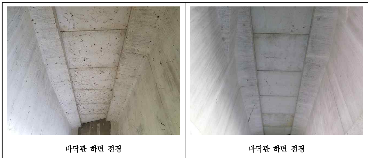
【사진 3.3.2】 바닥판하면 전경
