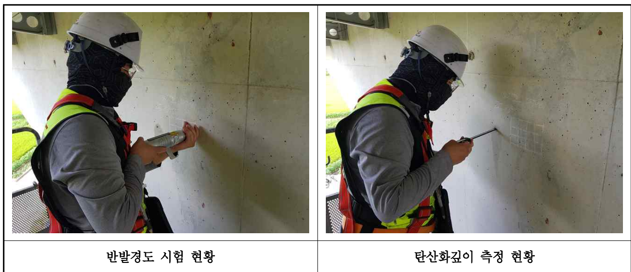
【사진 3.4.1】 콘크리트 내구성조사 현황
