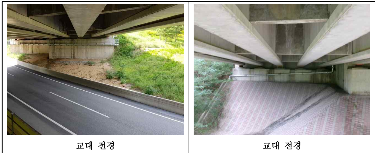
【사진 3.3.8】 교대 전경
