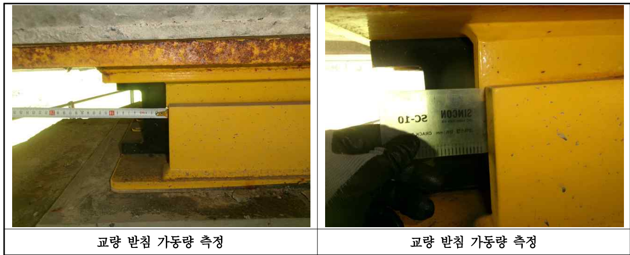
【사진 3.3.16】 교량받침 이동량 측정
