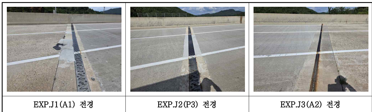
【사진 3.3.44】 신축이음장치 전경
