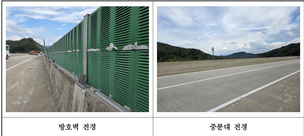
【사진 3.3.51】 방호벽 및 중앙분리대 전경
