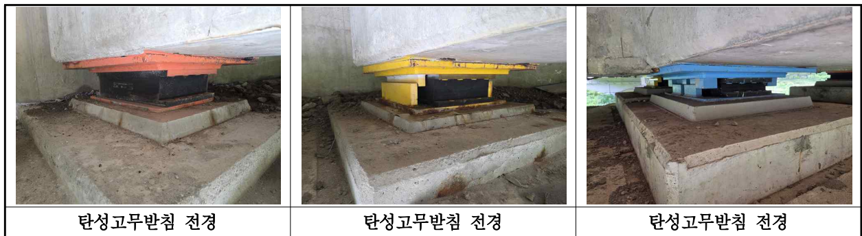
【사진 3.3.40】 교량받침 전경
