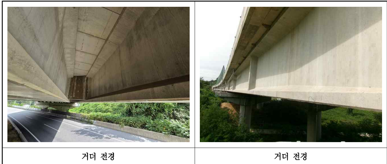
【사진 3.3.31】 거더 전경
