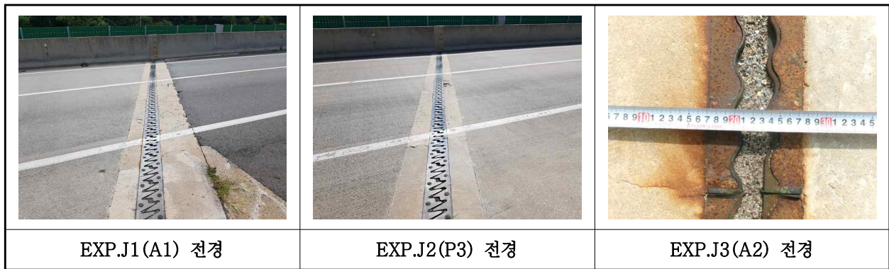
【사진 3.3.17】 신축이음장치 전경
