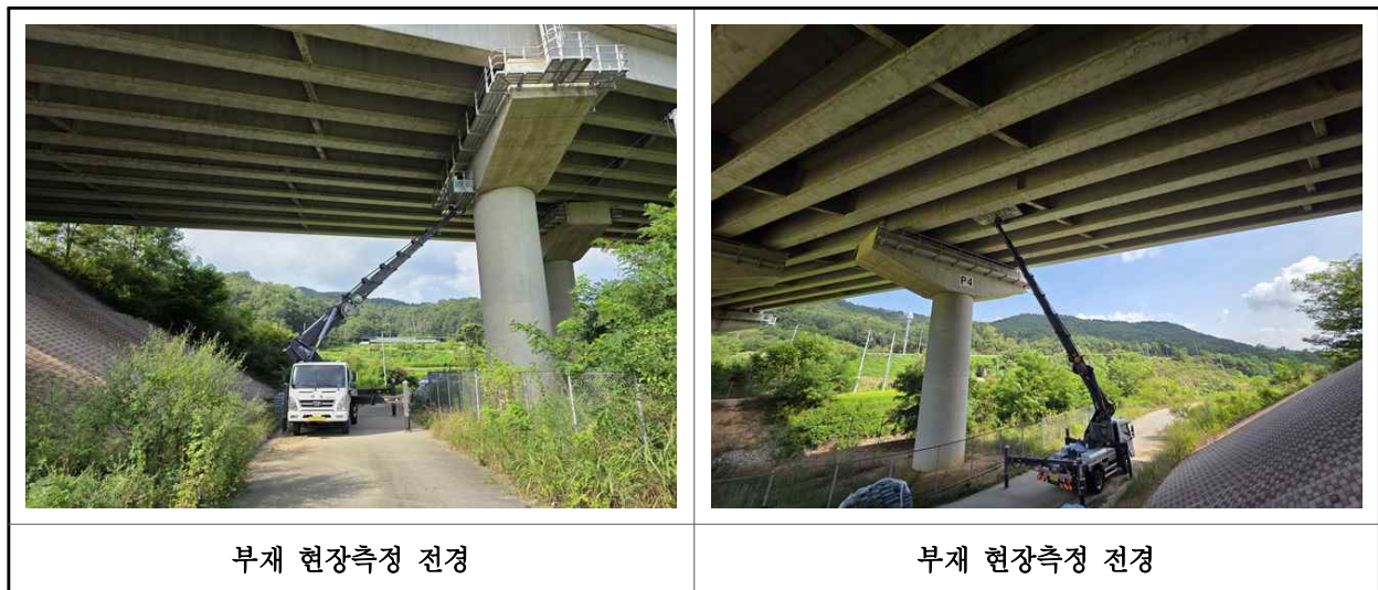
【사진 3.2.1】 부재 현장측정 전경
