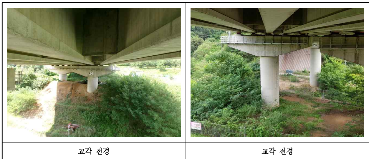
【사진 3.3.10】 교각 전경
