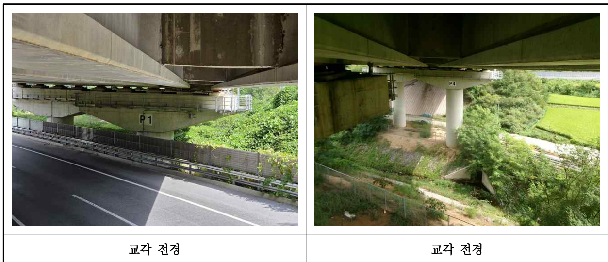
【사진 3.3.37】 교각 전경
