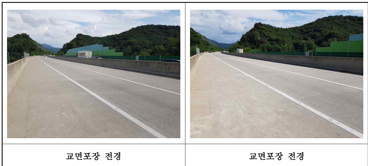
【사진 3.3.20】 교면포장 전경
